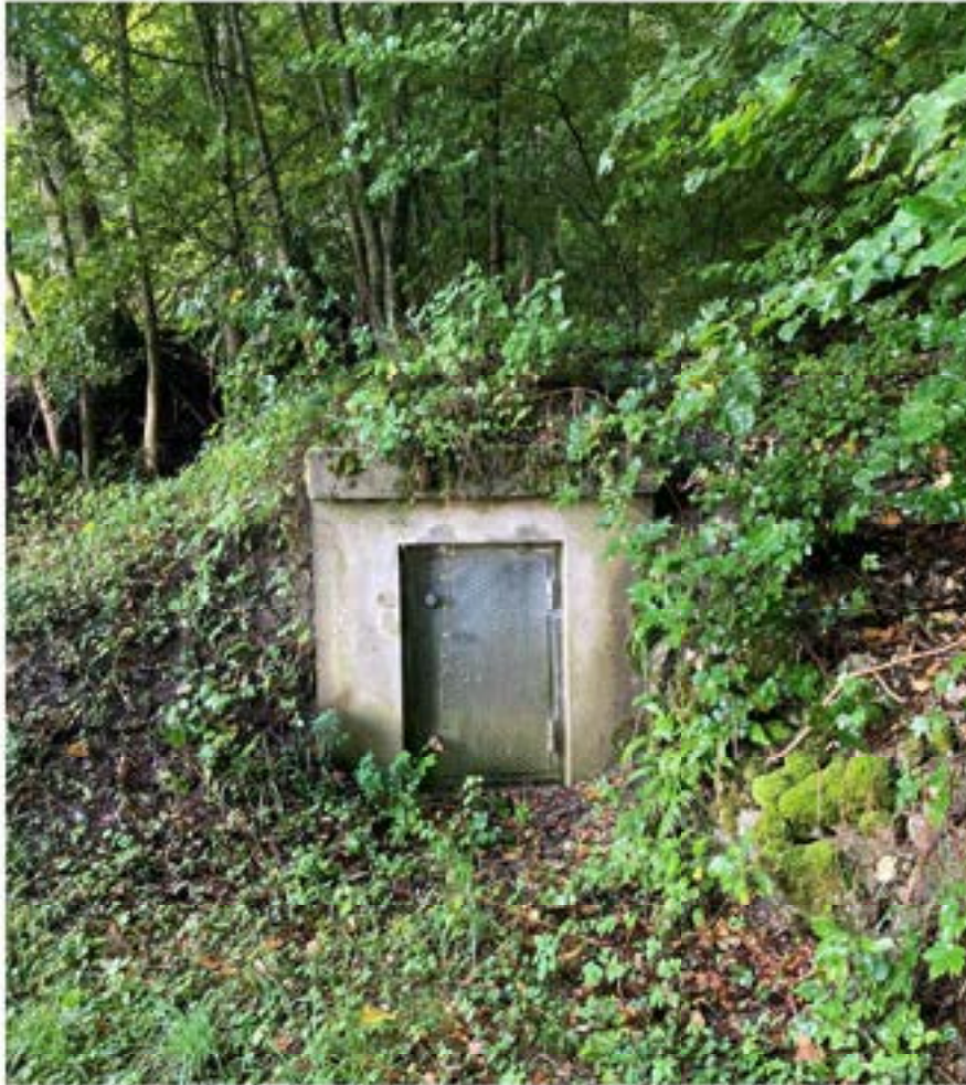
Alte Brunnstube Untere Lindquelle
